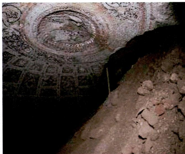
Fig. 10. Parte sudorientale della cupola ripresa dal sondaggio 11, si notino la parte mancante della volta da cui penetra lo strato di detriti che ha riempito il vano e uno dei tubi di rivestimento dei sondaggi (n. 9) caduto all'interno.
